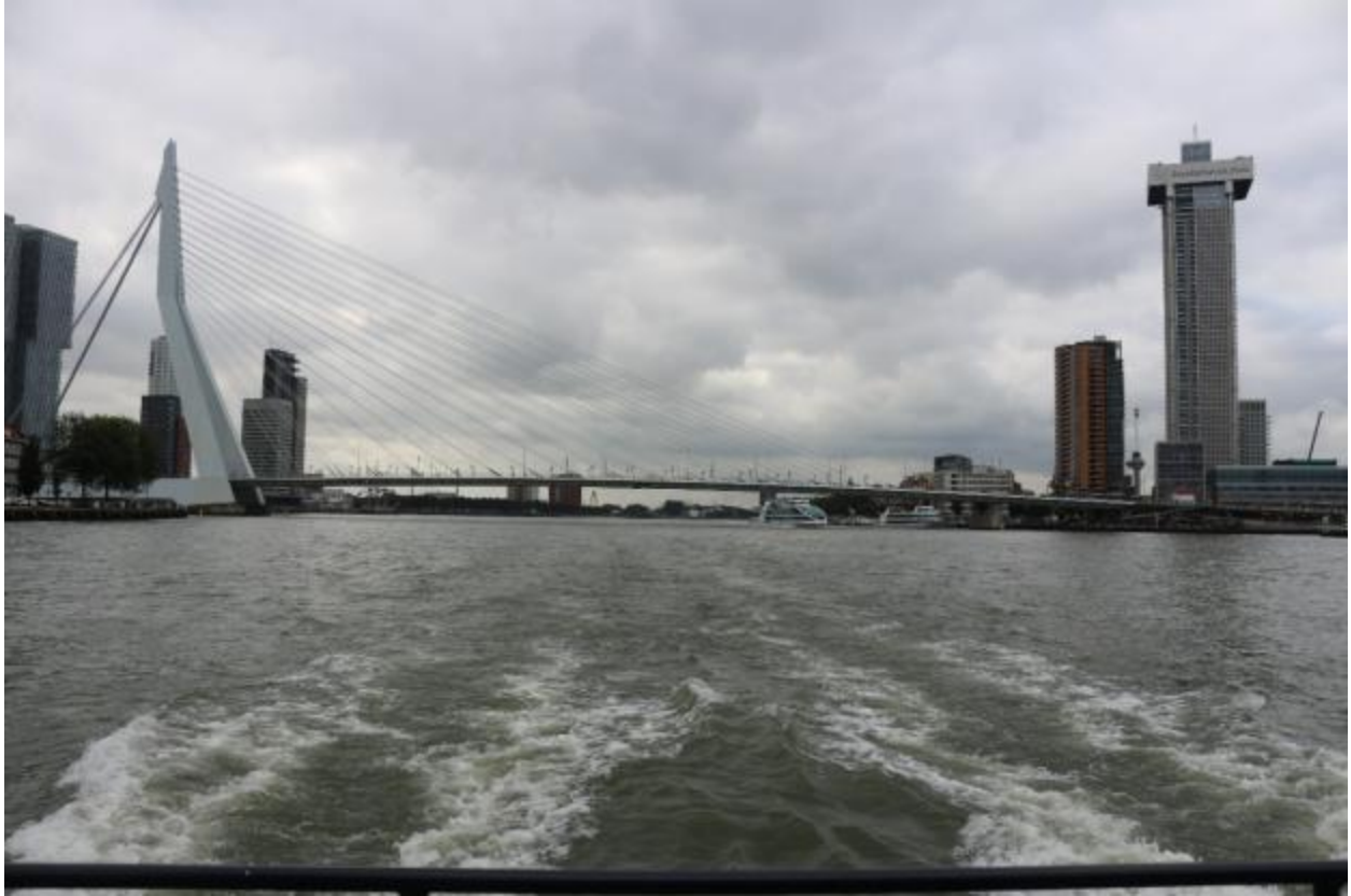
Erasmusbrug (Erasmus Bridge), Rotterdam
